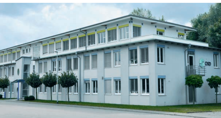
Bereits seit 1991 Hauptsitz des Unternehmens: Das OSD-Firmengebäude am Erlengraben in Ettligen
